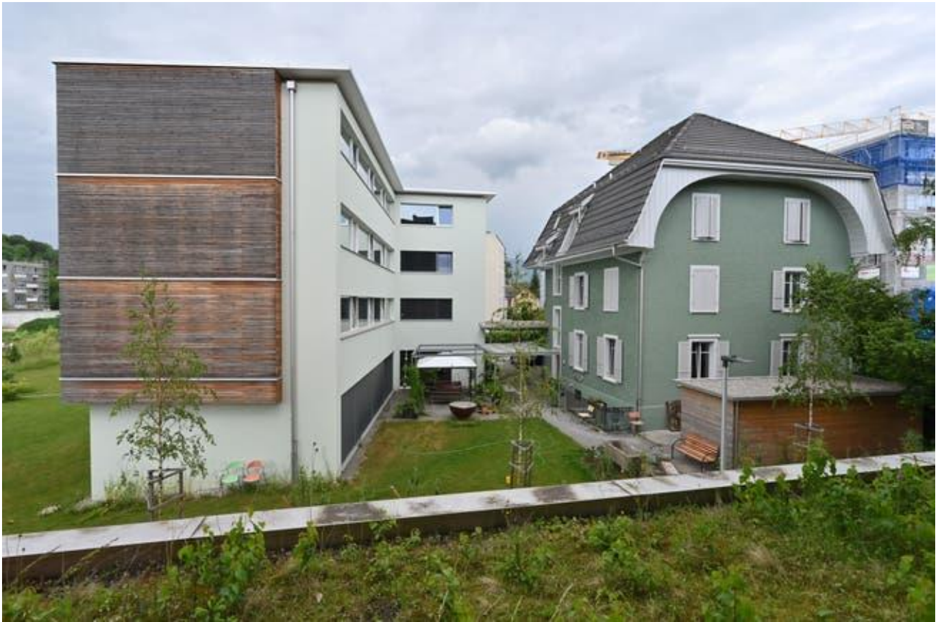
Die alte Villa Rosentau und der Neubau.
